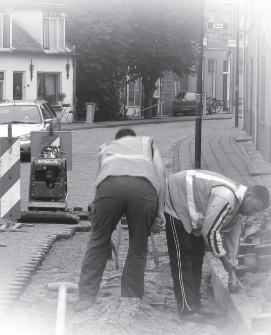
Vorbereidend werk in uitvoering aan de Dorpsstraat.
